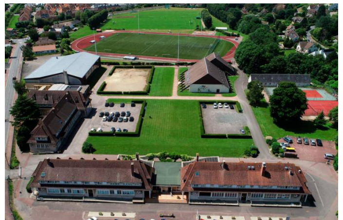
CENTRE SPORTIF DE NORMANDIE HOULGATE - 14510
